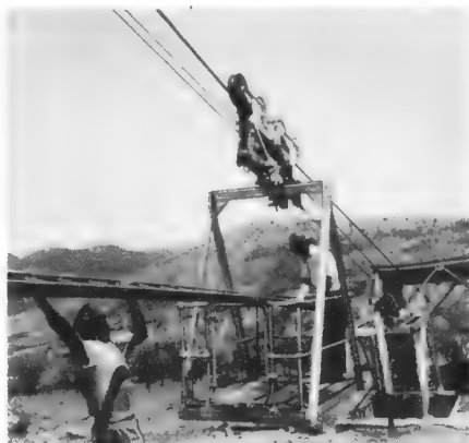
Bild 3. Beladen der einfachen Seilbahn bei der Station Rustenburg
